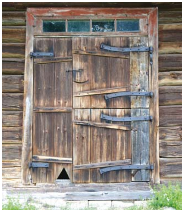
Hevostallissa on kolmiosainen luukkuovi hyvän tuuletuksen aikaansaamiseksi. Alaoven voi jättää kiinni, jolloin ei synny vetoa, mutta ilma vaihtuu.
