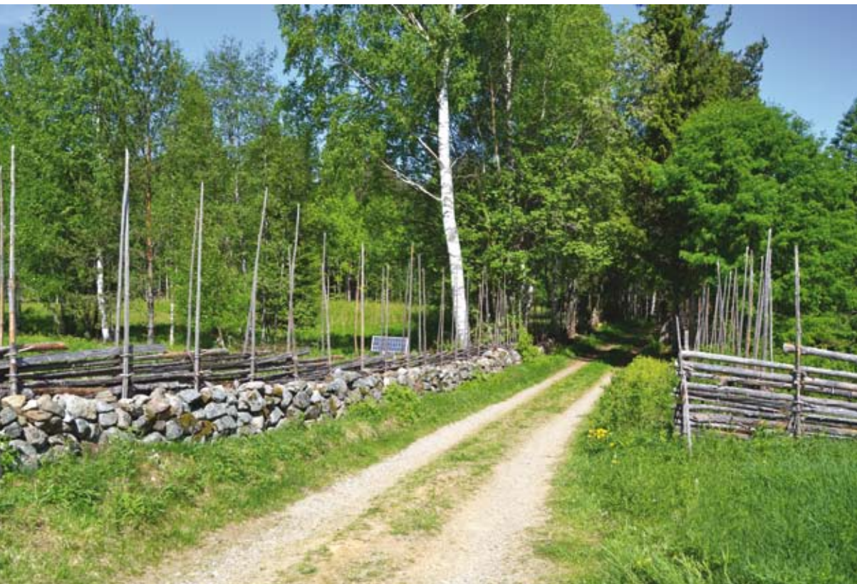
Kivijalustaan pystytetty aita voi kestää jopa 30 vuotta.
